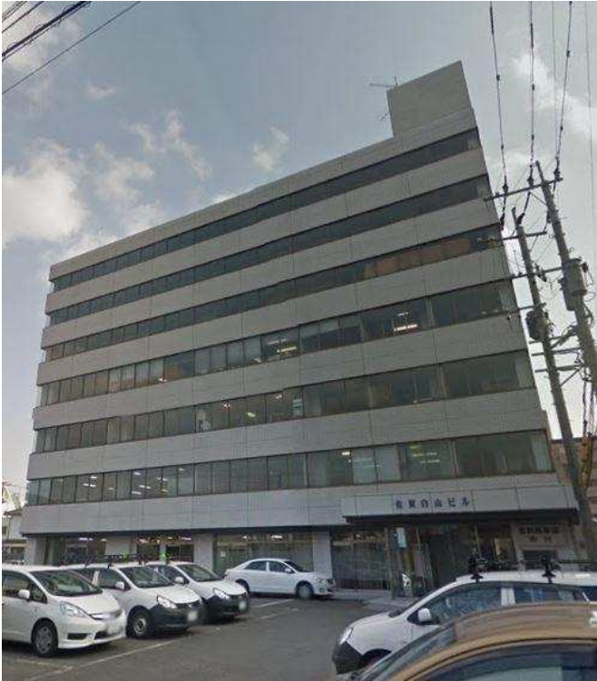
建物外観写真
